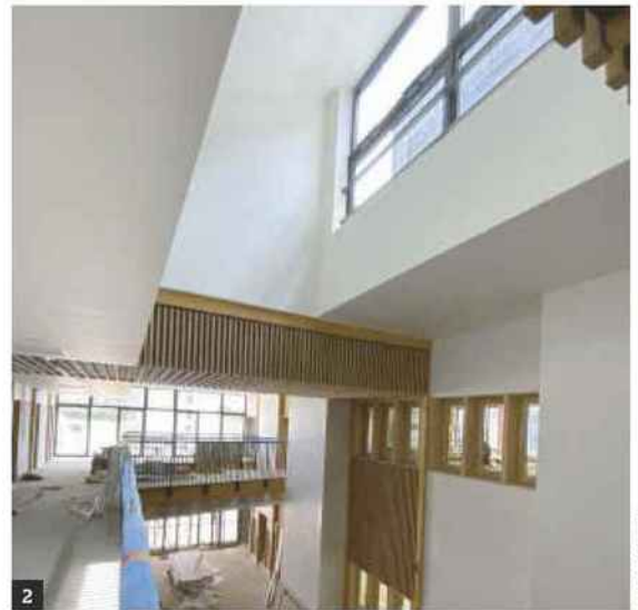
1 - Le système de rues intérieures repose sur une ventilation et une lumière naturelles. 2 - Chaque rue se compose d'un jeu de passerelles et de trémies, surmontées de sheds.
