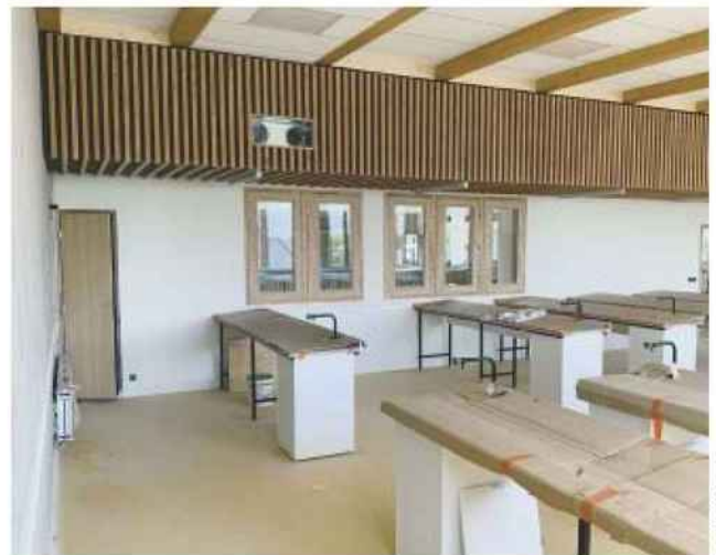
Le bois habille ici le caisson technique d'une salle dédiée aux sciences.
